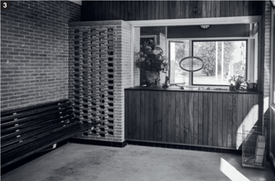
3. De wand links van het loket had een opvallend open metselwerk. Erachter stond een oliekachel en de openingen in het metselwerk zorgden ervoor dat ook de wachtruimte enigszins werd verwarmd. Collectie: Utrechts Archief Nederlandse Spoorwegen.
